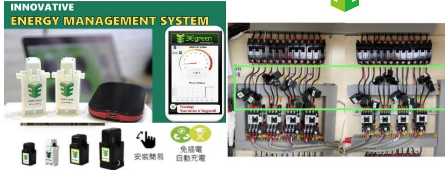
圖一:電流指示器-實際安裝圖
